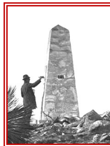
Mon. No. 141 (Masonry)
