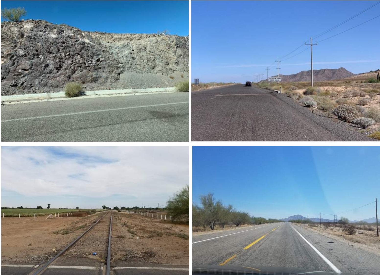
Figure/Figura 14 Representative pictures of the potential pipeline route Imágenes representativas de la ruta potencial de la tubería
