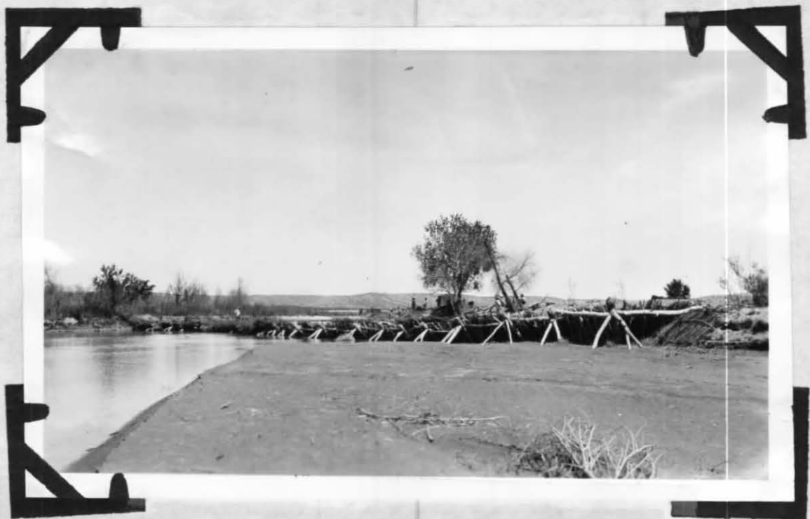
Río Grande.- Diversion dam at Haciendita, Texas.
